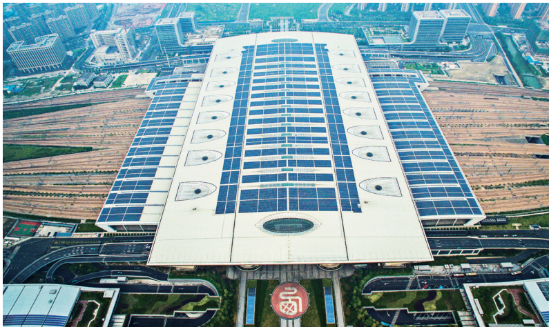
◎ 杭州火车东站10 MW屋顶光伏电站
