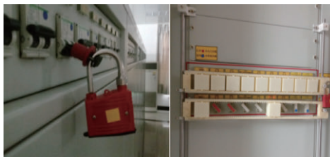
图5 闭锁实施现场
