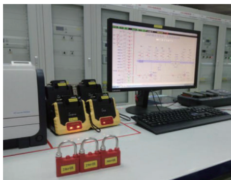
图4 电厂检修隔离与管控系统
