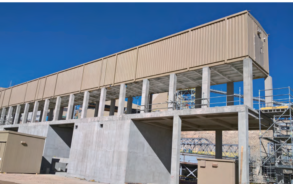
© 秘鲁 Toquepala 铜矿项目现场
