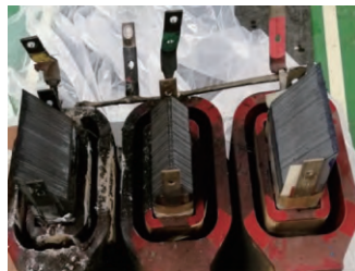
图2 故障变压器拆除上盖图
