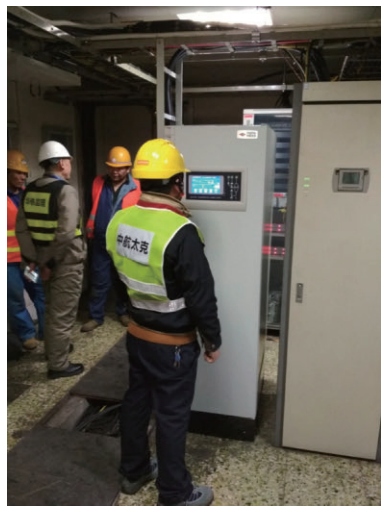
◎ 北京地铁安装调试现场
