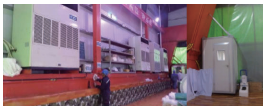
图4 移动式装配车间的环境控制设施布置
