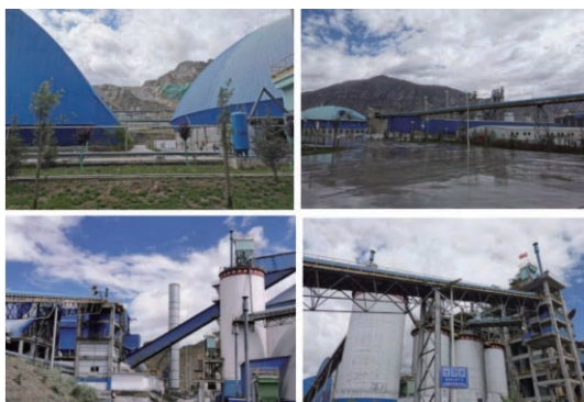
图1 拉萨高争水泥厂皮带廊项目
