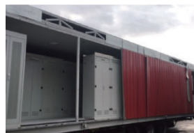
(b) 运输途中预制舱封板情况图
