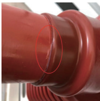
图13 涂抹的高压绝缘硅脂
