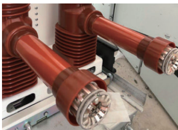
图14 硫化涂覆工艺后的断路器触臂
