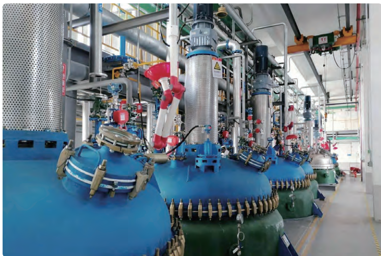
原料药生产车间一角
