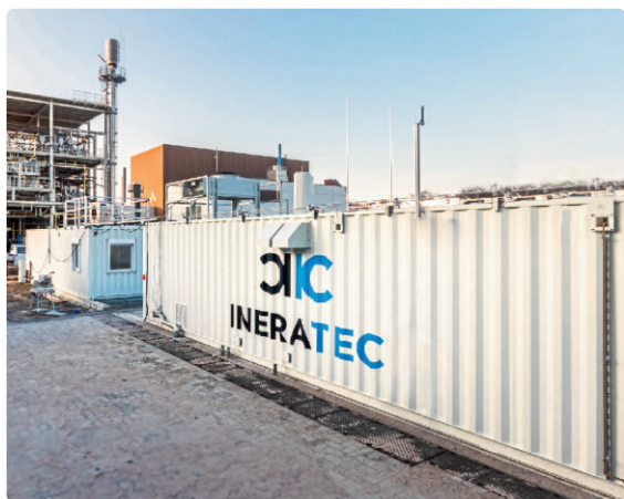
集装箱中的化工厂：KIT 卡尔斯鲁尔理工学院的展示设备清楚演示了 Power-to-X 紧凑的生产过程
