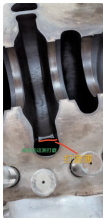
图3 泵壳隔舌照片
