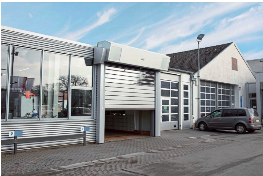
图 3 Autohof Reimers 公司的员工对 Assa Abloy 公司研发生产的 RR3000 型高速门赞不绝口
