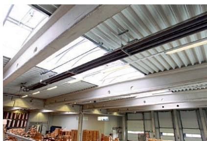
图 1 双管红外辐射器调节着拣选配货工作站处的温度
