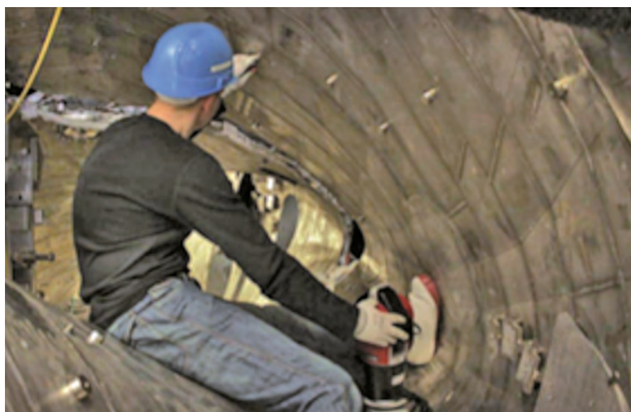
图 2 使用 API Radian 激光跟踪仪在聚变反应堆等离子体容器中进行测量作业
