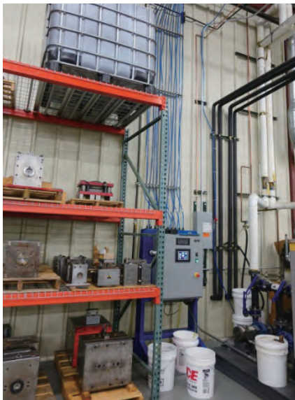
图 3 不同的流水线将冷却剂送到不同的设备上，图中上方的储罐里装的是浓缩液。系统在工作期间表现优异，Precision Tool Technologies 希望能够在其他车间进行技术推广
