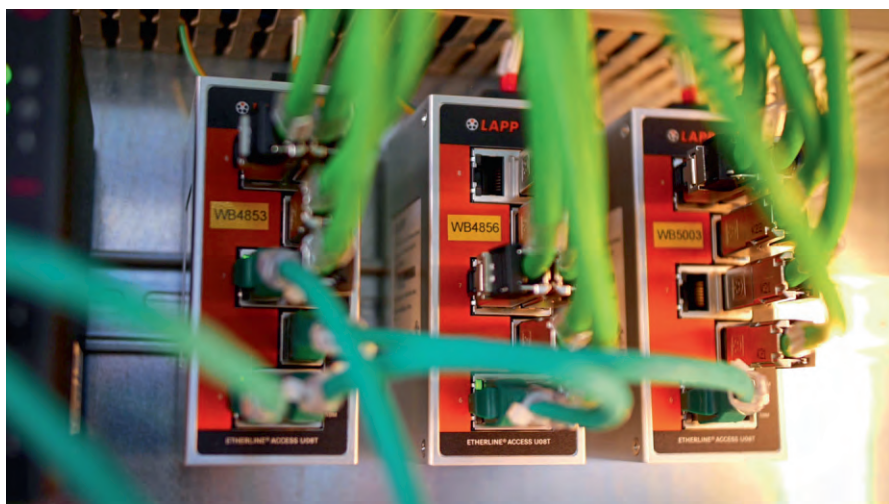
图 2 作为一个工业化数据传输解决方案的例子：以太网接入工业交换机 U05T 和 U08T
