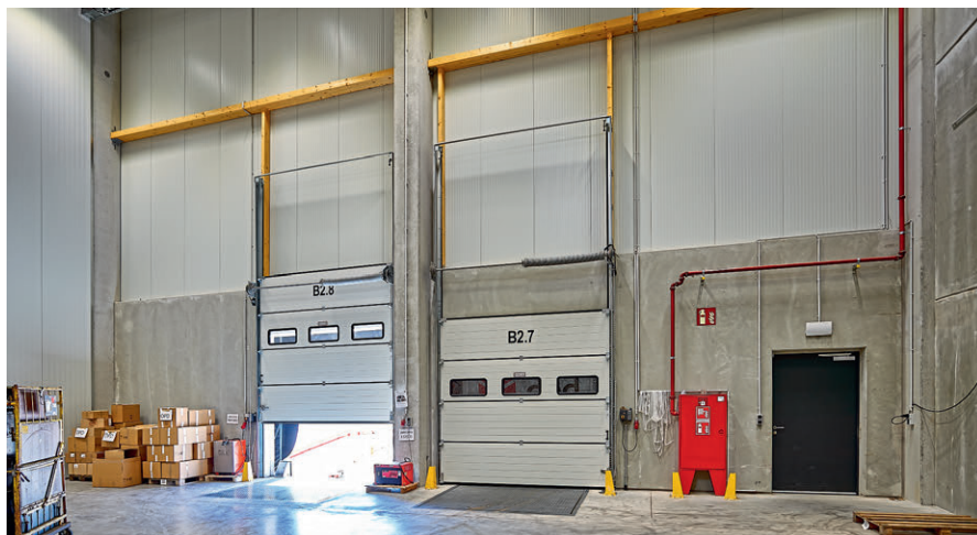
图 3 Hörmann 公司开发生产的向上开启式卷帘门应用在 Erlensee 物流中心
