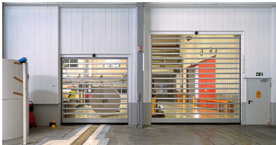
图 4 根据用户对室内光线的需要为 EFA-SST 高速门配备不同数量的 EFA-Clear 透光板条
