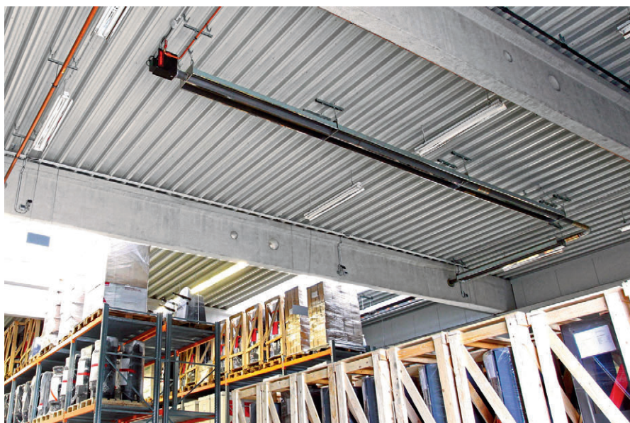
发货运输库区中的直线型热辐射散热器
