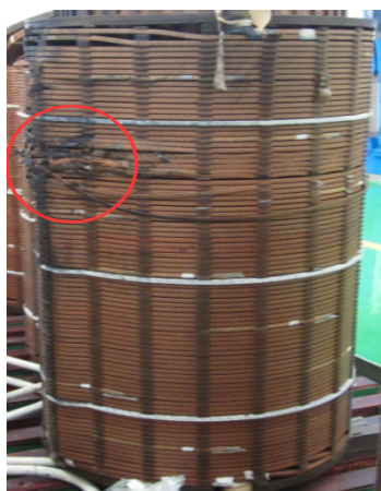
图6 变压器解体吊罩结果
