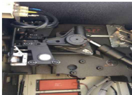
图1 断路器处于合闸位置分合闸掣子装置位置
