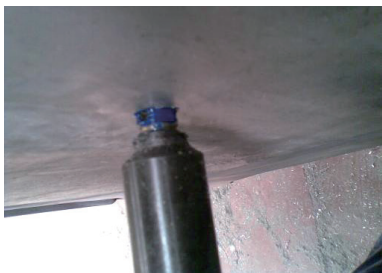
图1 钢螺套的安装
