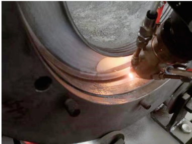
图5 抱轴箱轴承孔激光熔覆焊修
