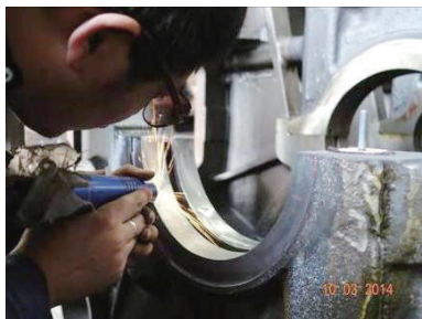
图2 机体主轴承孔修复
