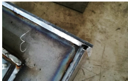
图5 焊接试验焊缝质量
