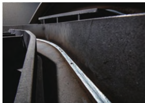
图11 PMC Twin工艺焊接的钢结构产品
