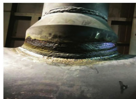
图3 重新焊接合格后的焊缝
