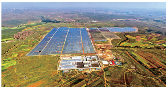
图1 国家风光储输示范工程
