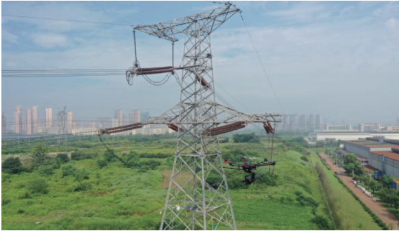
图8 现场检测场景
