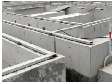
图5 基础通长预埋件效果图
