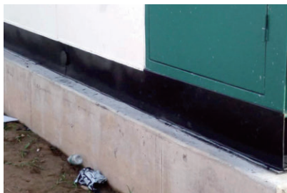
图3 侧面封堵方案实际效果图
