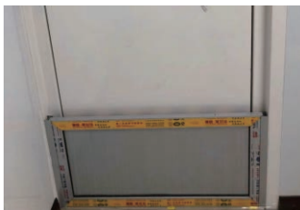
图3 舱门设防鼠板实物图
