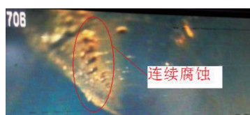
图4 部分泄漏管道：怀疑泄漏位置从管板处向内 0.5 m 左右，连续腐蚀小坑
