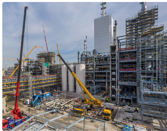
路德维希港的大型工业项目对项目处理，特别是脚手架施工提出了很高的要求
