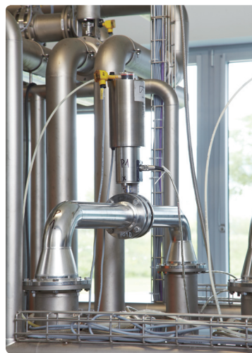
图 3 科德宝密封技术在德国温海姆的室内试验台
