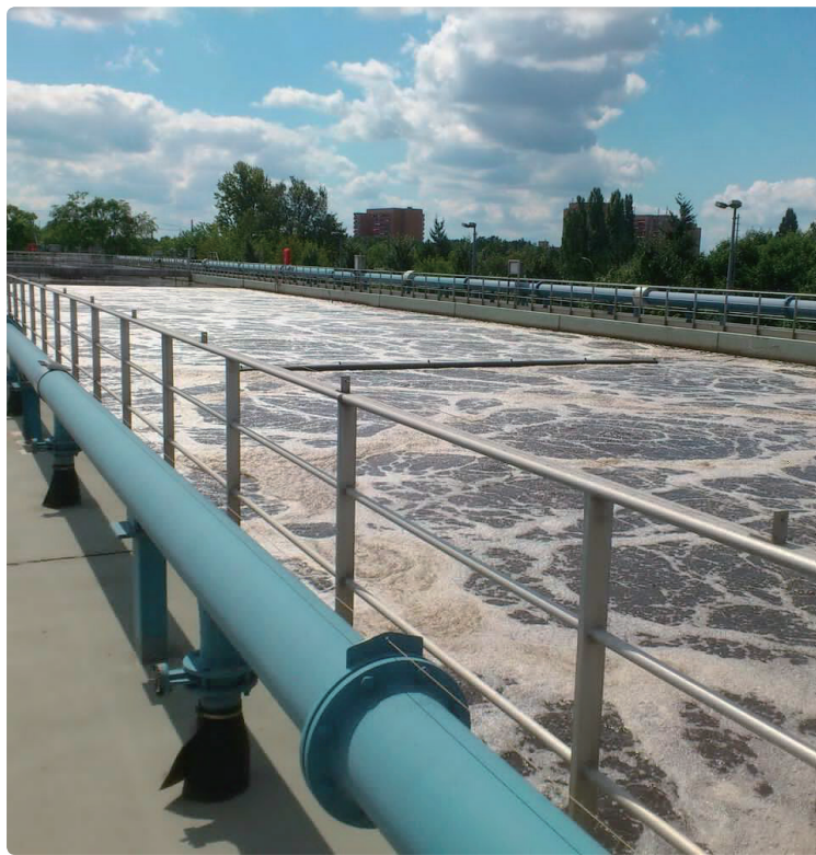
Variolytics 开发的新型分析平台可用于污水处理系统的生物净化阶段，既可以监测曝气池内对环境有害的气体，还有助于减少这些气体的产生
