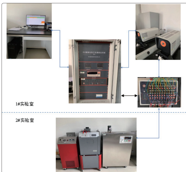
图2 改造后的热工检定系统
