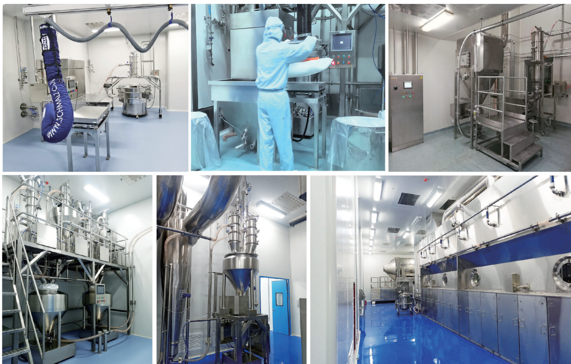
全密闭自动化颗粒剂联线生产系统现场实拍
