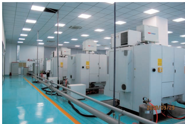
图5 刃天行 SKYWALKER 常州工厂一角
