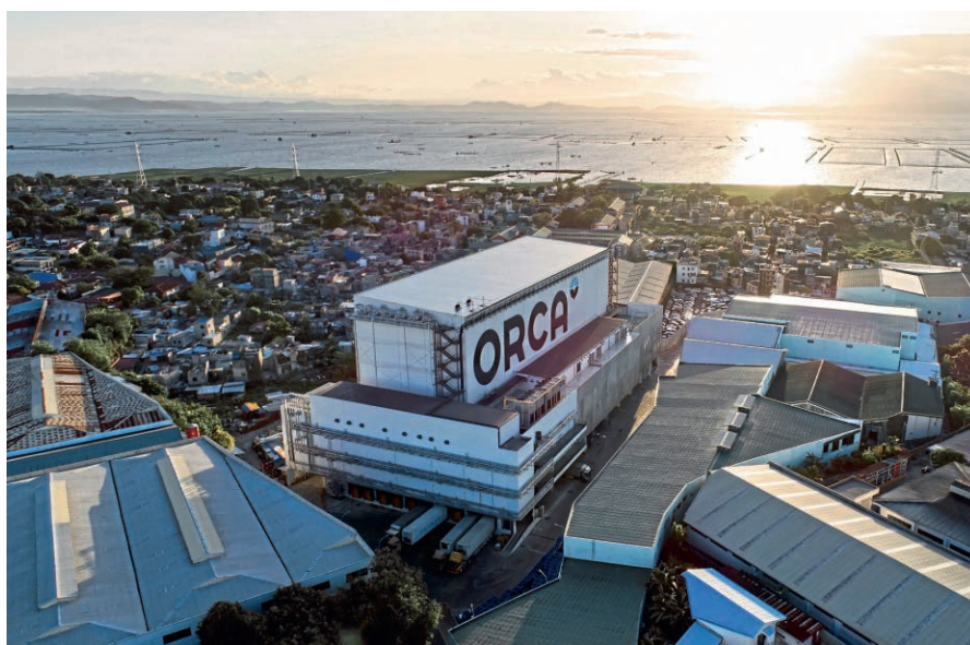
图 2 ORCA 公司的全自动高架立体库的设计具有很高的抗地震、抗台风性能，每天可以完成多达 4800 托盘的物资出入库
