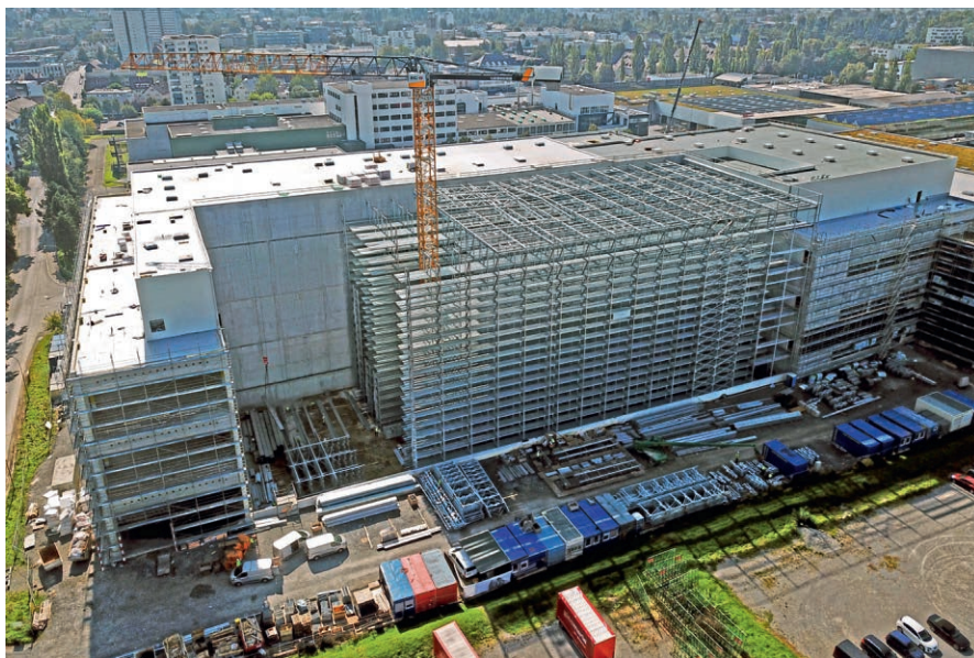
起重设备是高架立体库建设过程中的重中之重
