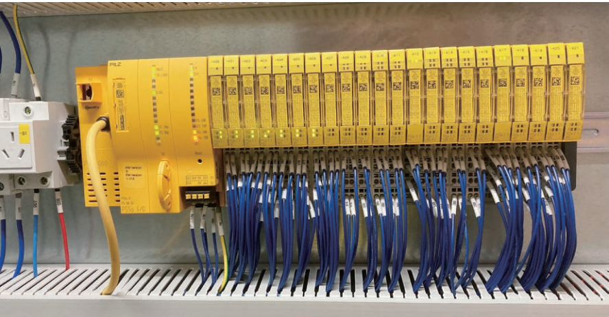
图 2 PSS 4000 设备之间通过 FS/ST SafetyNET p RTFN 进行数据交换
