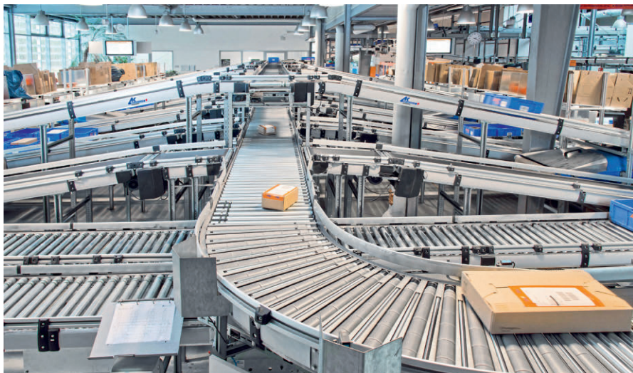
图 在现有包装车间的基础上扩建一个新的物流大厅
