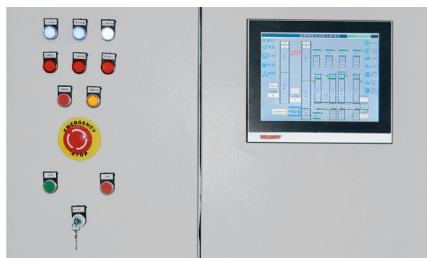
图2 控制柜中的嵌入式控制器与用人机界面的倍福控制面板 CP2912 相连
