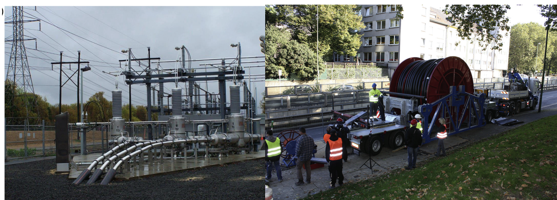
图 1 美国 LIPA 工程(左)及德国 ESSEN 工程(右)穿管敷设
