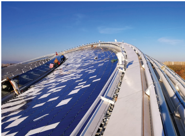
图 12 屋面太阳能光伏板及外沿射灯
