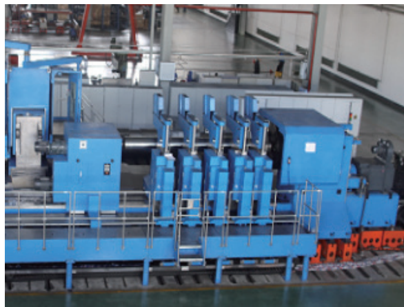
图3 高精度数控中心架应用现场
