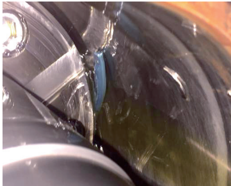
图9 增压器内部密封件老化破裂
