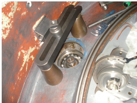
图5 螺母顶压法拆卸传动Ⅱ轴
