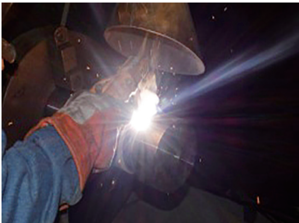
图4 焊条偏离角度试验
