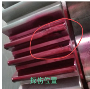
图3 无损检测位置
