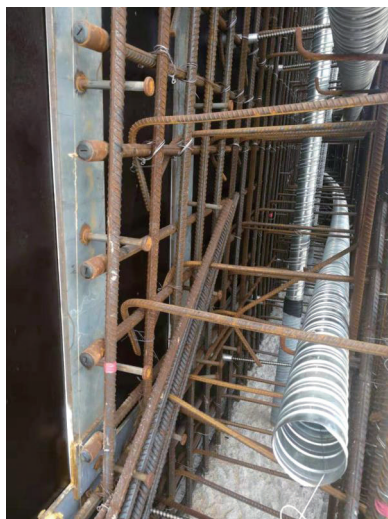
图2 外罐防潮衬板预埋件栓钉
